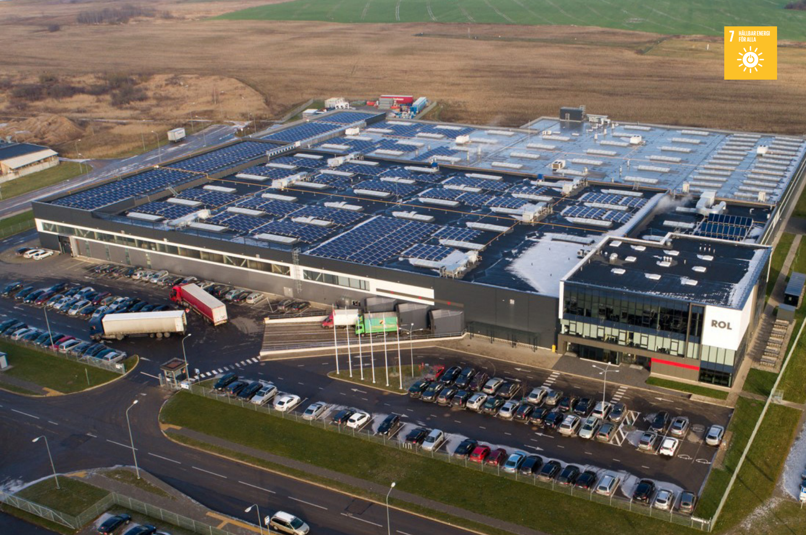
Solpaneler installerades 2018 på vår fabrik i Litauen.
